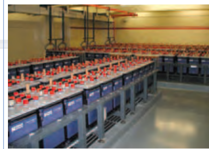
Рис. 13 Смонтированные батареи Classic GroE
